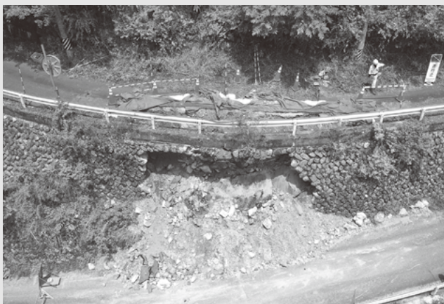
村道5号線上平工事箇所
