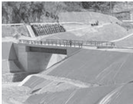
復旧が進む加々須崩落現場
