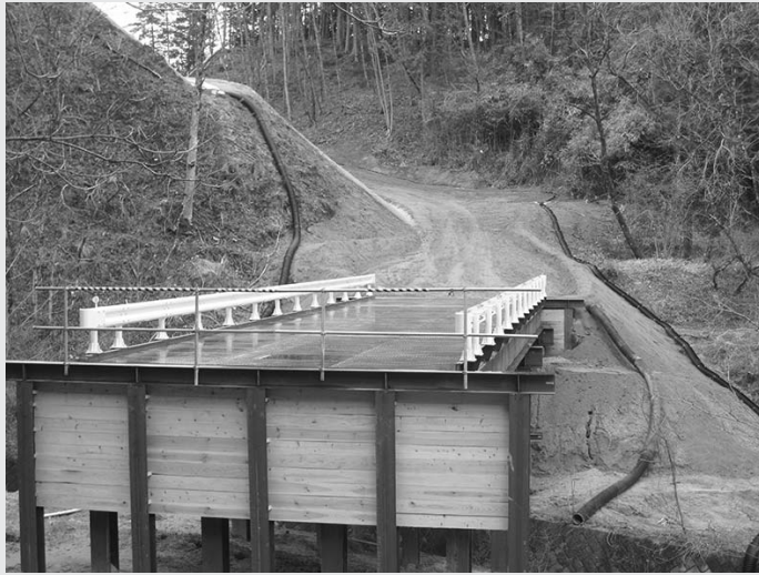
工事の進む取付道路
