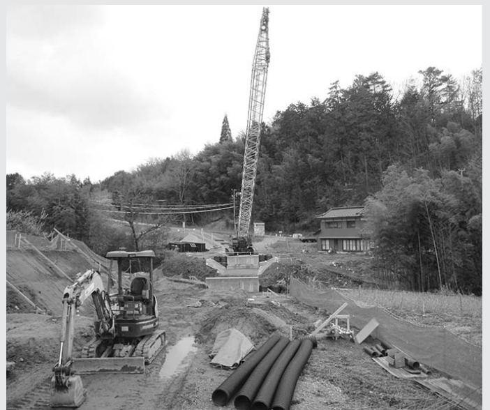
工事着手した富田バイパス
