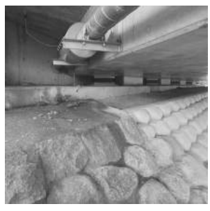
新小川渡橋の橋台点検
