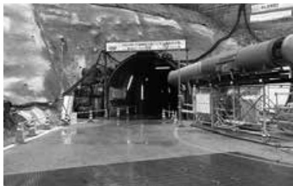
青崩峠トンネル調査坑 長野県側坑口
