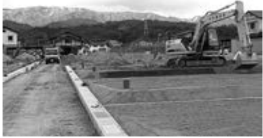
造成中の中原住宅団地
