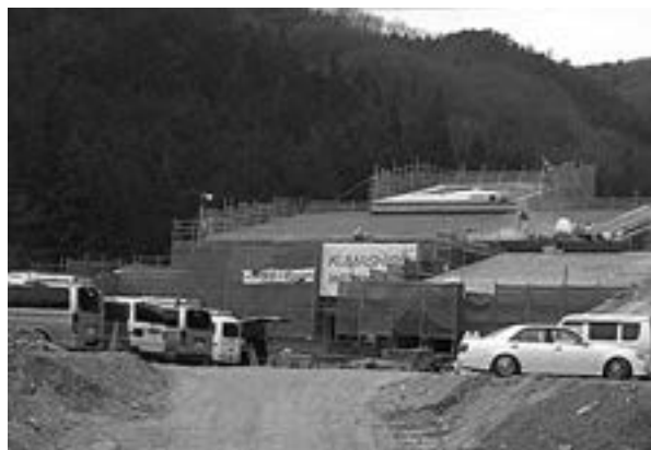
工事の進む北部地区火葬場
