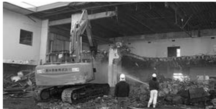
解体のすすむ元JA喬木支所
