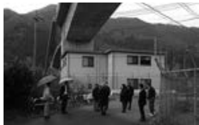
高架橋下での騒音確認
