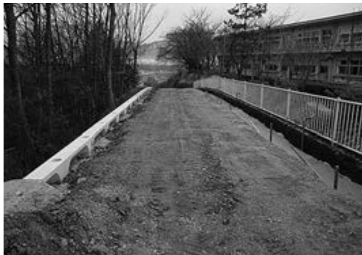
学び坂拡幅工事
