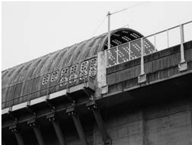
騒音と微気圧波を抑える緩衝工
