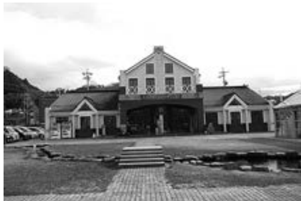
現在の交流センター（平成3年施工）
