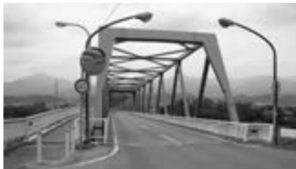
拡幅が望まれる阿島橋
