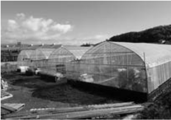
建設中の農業用ハウス
