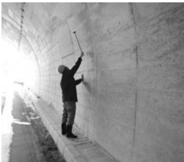
防犯カメラが設置される上平トンネル
