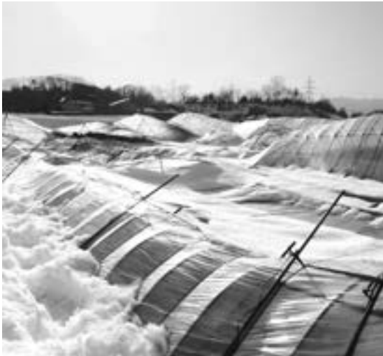
倒壊したパイプハウス
