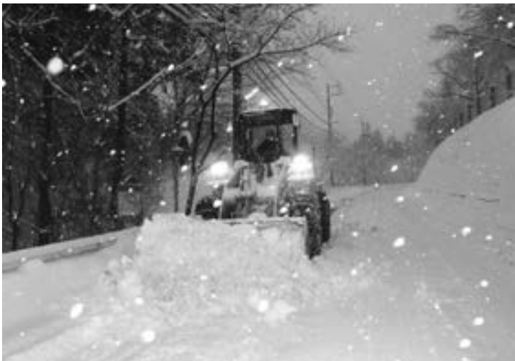
村道の除雪作業
