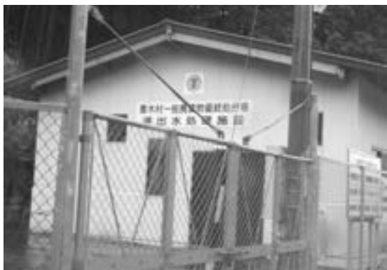
最終処分の浸透水の処理施設
