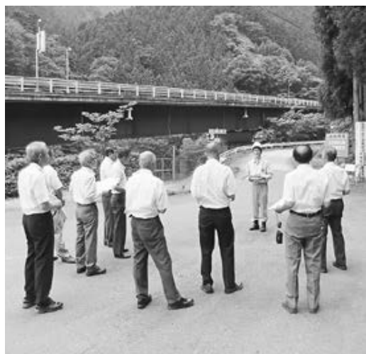
議員による青崩トンネル浜松側の坑口付近
