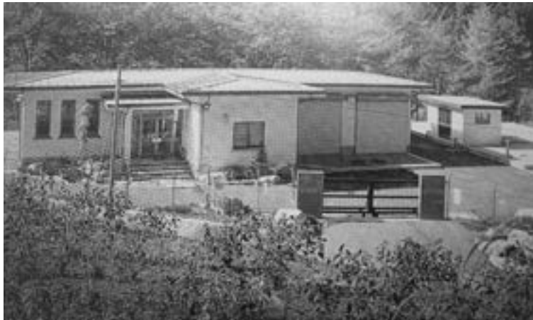
二日洞水源地
