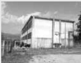
解体される旧中学校校舎
