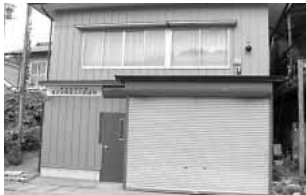
耐震工事が終わった消防詰所
