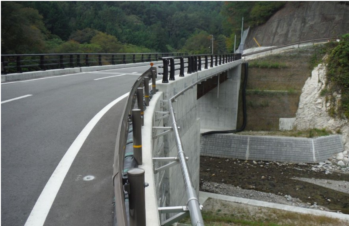
新三枚添橋 水管橋
