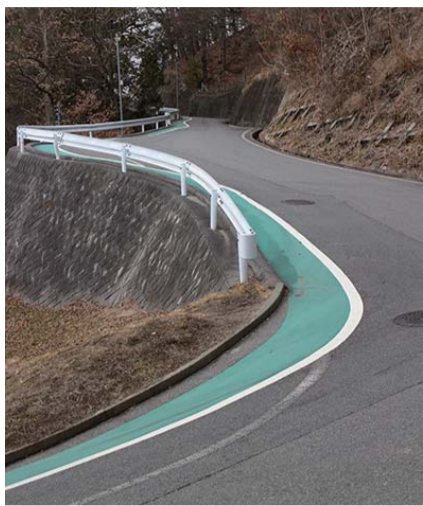
学び坂は、安全な通学路となるよう現在工事中
