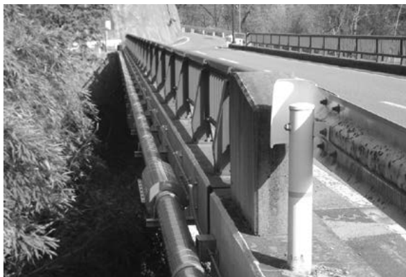
大島宮沢橋水管橋
