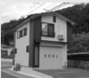
改築された伊久間消防詰所
