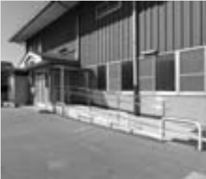
バリアフリー工事が行われた第一社会体育館
