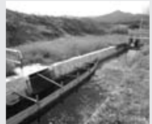
改修された竜東井堰下サイフォン
