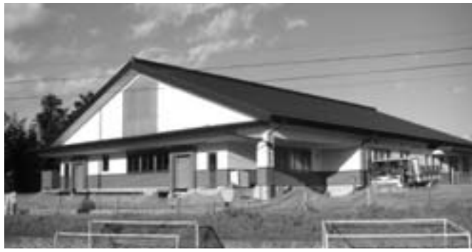
12月末の完成に向け 工事の進む学校給食共同調理場
