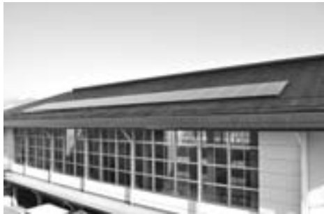
中学校体育館太陽光パネル
