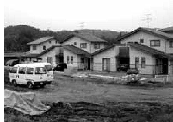
富田若者定住住宅(第2期・3棟) 隣地では第3期造成工事が行なわれています。
