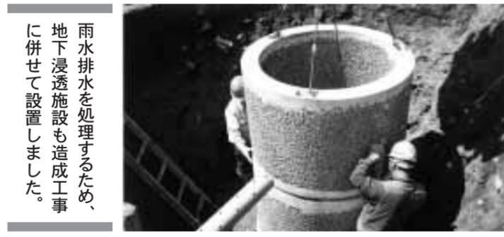
雨水排水を処理するため、地下浸透施設も造成工事に併せて設置しました。
