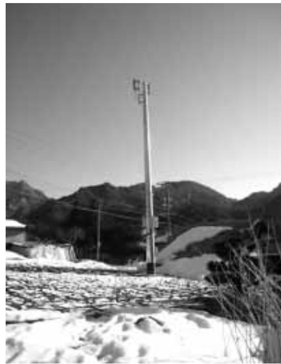
大島地区に村が建設した携帯電話の鉄塔
