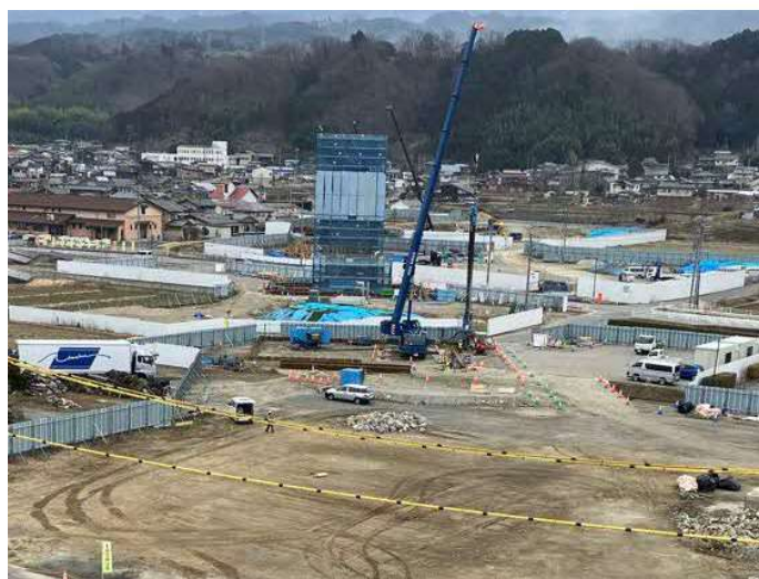
橋脚工事の様子
