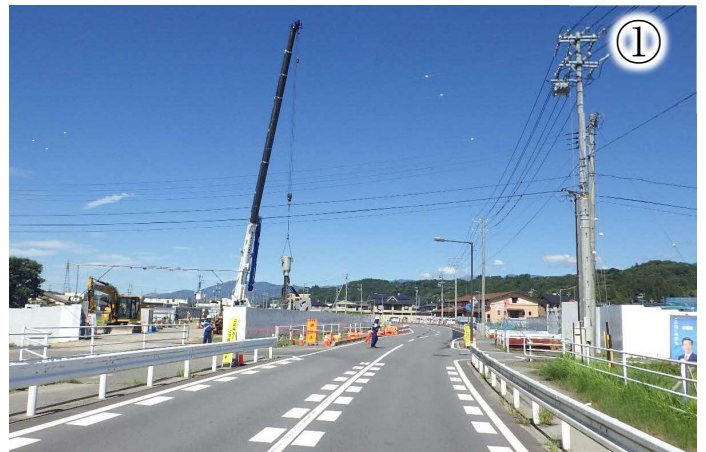
竜東一貫道路の車線切替完了
