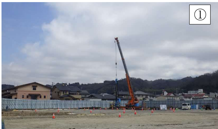
基礎工事の様子
