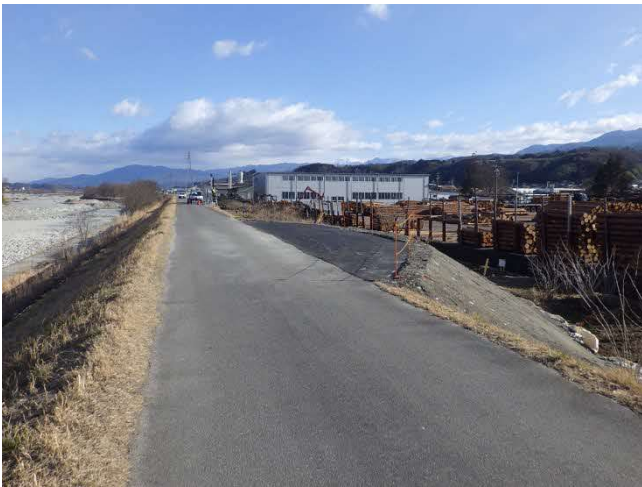
写真1 (車両すれ違い時の待避所)
