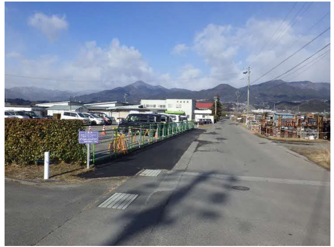
写真2 (車両すれ違い時の待避所)
