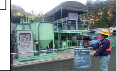
・工事排水の適切な処理 ・工事排水の監視 ・放流時の放流箇所及び水温の調整
