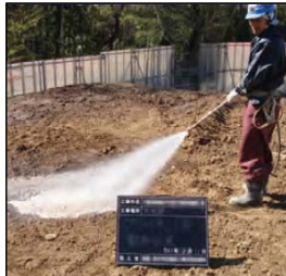
・工事現場の清掃及び散水
