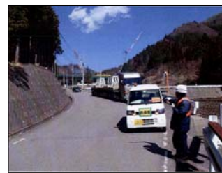
・車両の出入り口や周辺道路の清掃及び散水、タイヤの洗浄 ・荷台への防塵シート敷設及び散水
