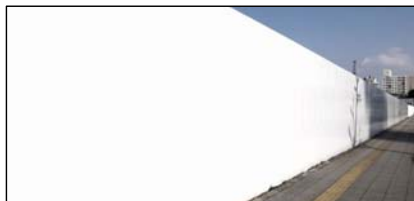
・仮囲い・防音シート等による遮音対策
