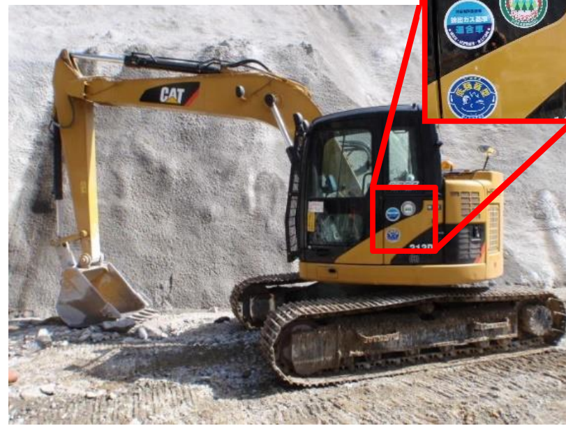
排出ガス対策型、低騒音型 建設機械の採用
