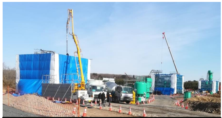
⑥ 橋脚部コンクリート打設
