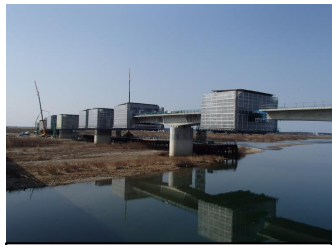
③張出施工
