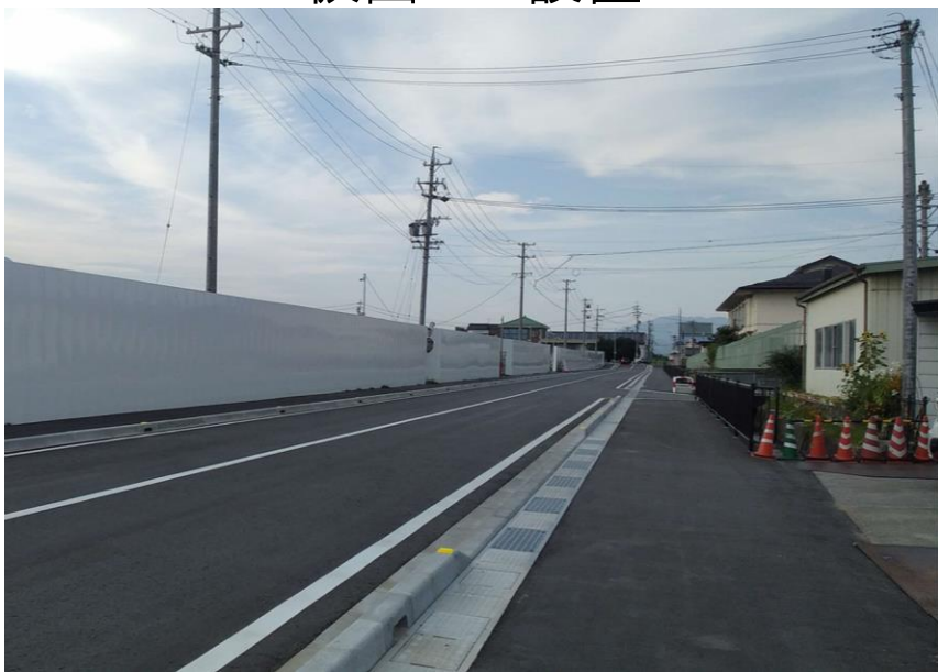
仮囲いの設置
