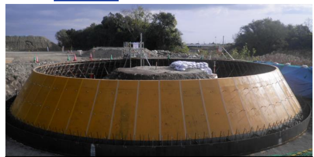
①作業室構築
