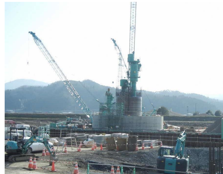
ニューマチックケーソン工法施工例
