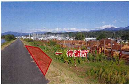
写真1 (待避所の設置箇所)
