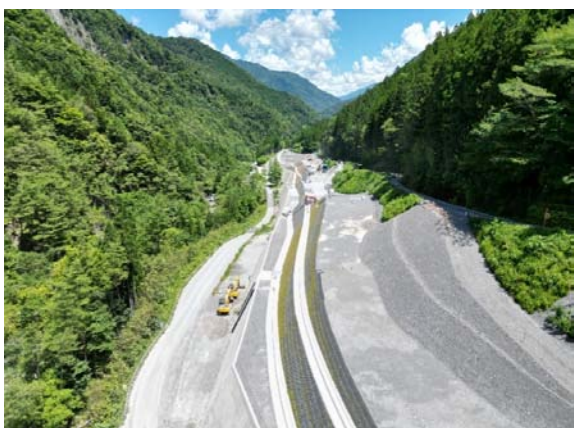
工事着手前(終点より)
