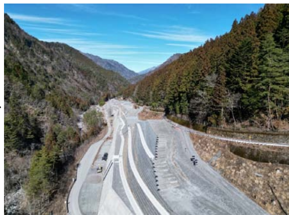
工事完了(終点より)
